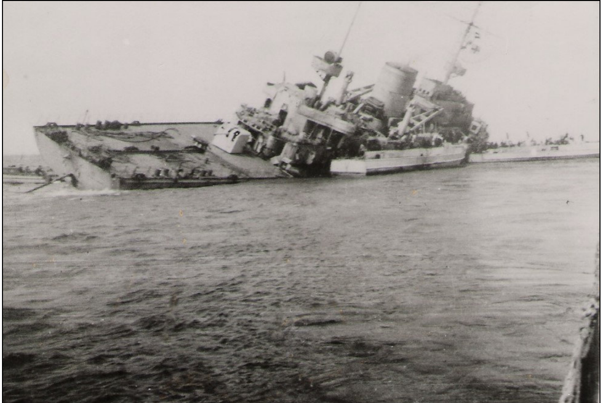
Die „Carl Peters“ geht in die Tiefe (Foto: Struppe)
